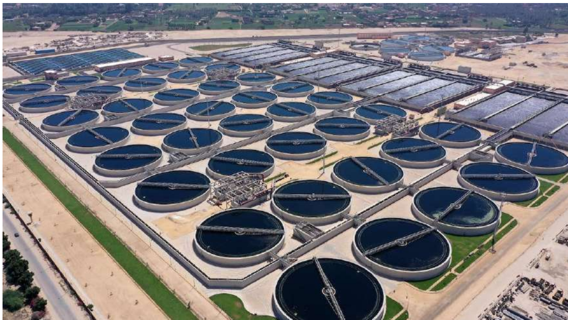
Estación aguas residuales de Aqualia Abu Rawash Egipto.
