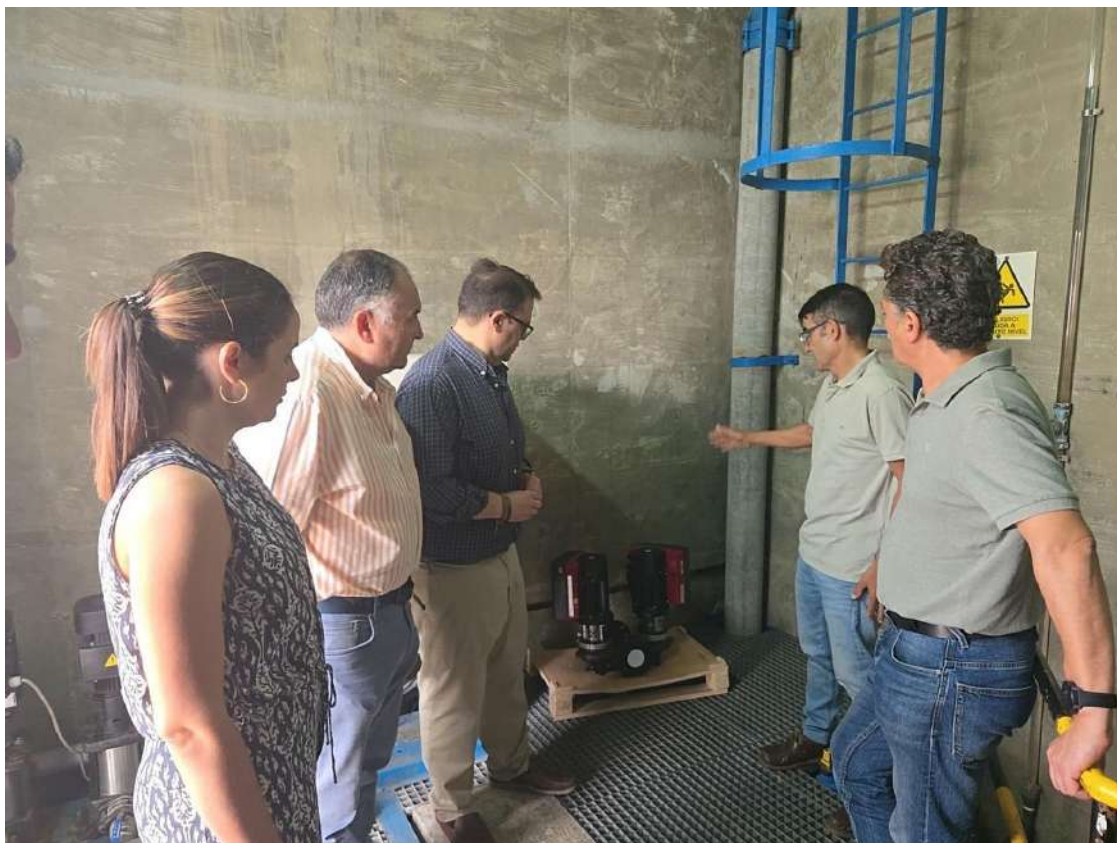
Una visita al depósito de agua potable del casco histórico
