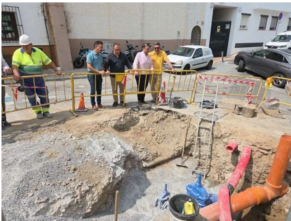
Finalizan las obras de sustitución de la tubería en la calle Real de La Herradura
